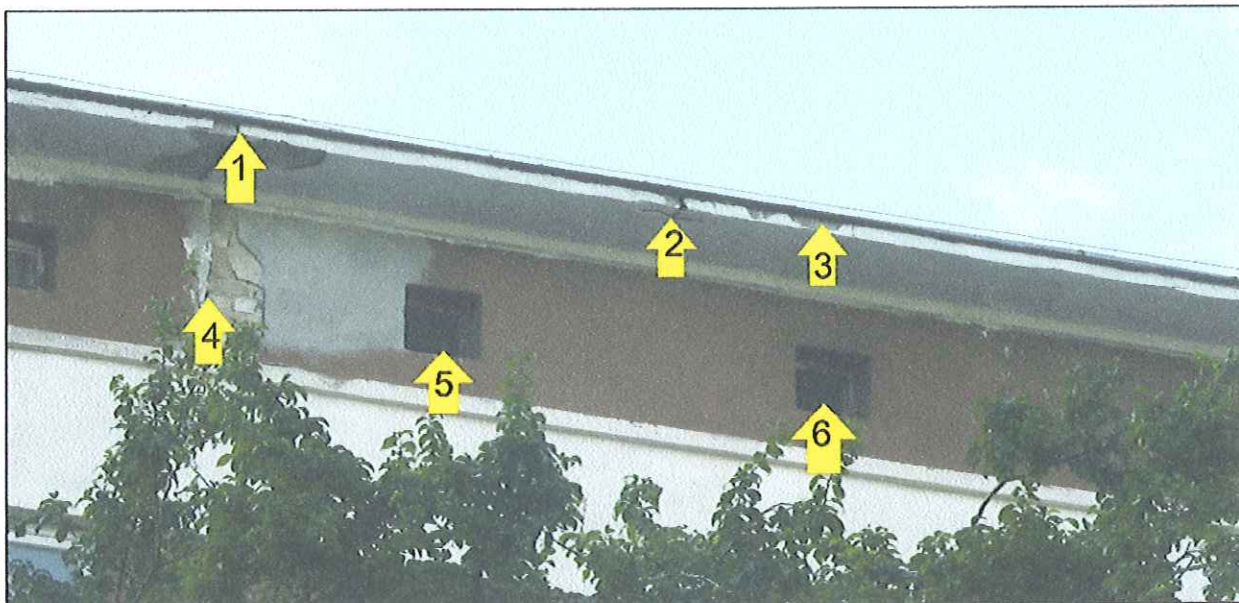
Fot. 2. Miejsca występowania ptaków i /lub nietoperzy (środkowa część elewacji południowej). 1, 2 i 4 - szpary między płytami, 3 – szpara pod obróbką blacharską, 5 i 6 otwarte wloty do przestrzeni stropodachu.
