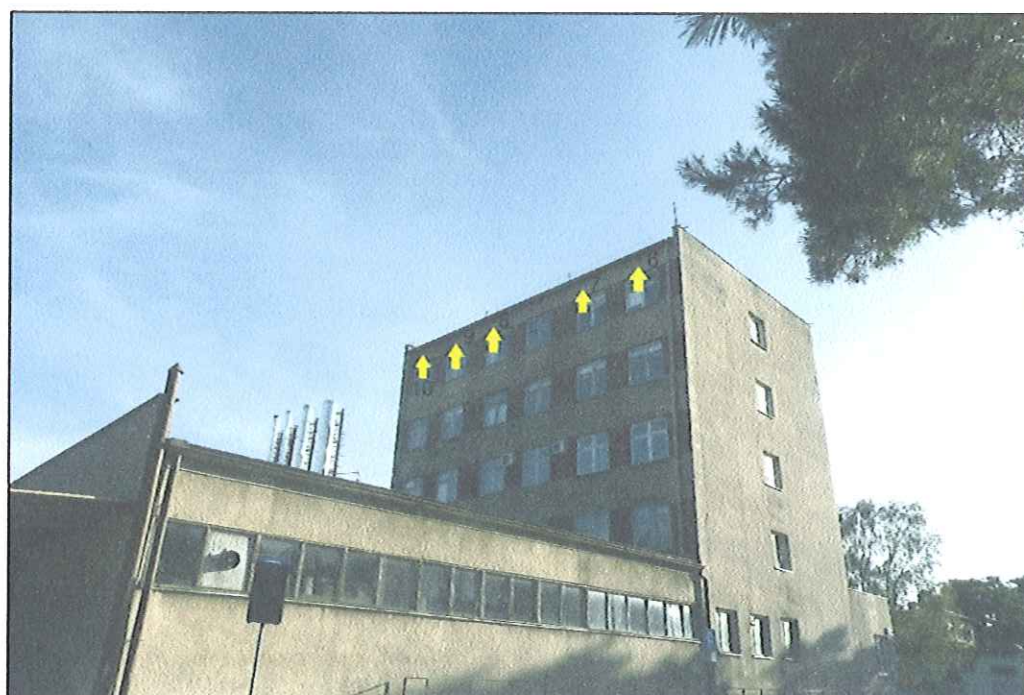
Fot. 28. Elewacja wschodnia budynku nr 9 z zaznaczonymi niezabezpieczonymi wlotami (6-10) do przestrzeni stropodachu.
