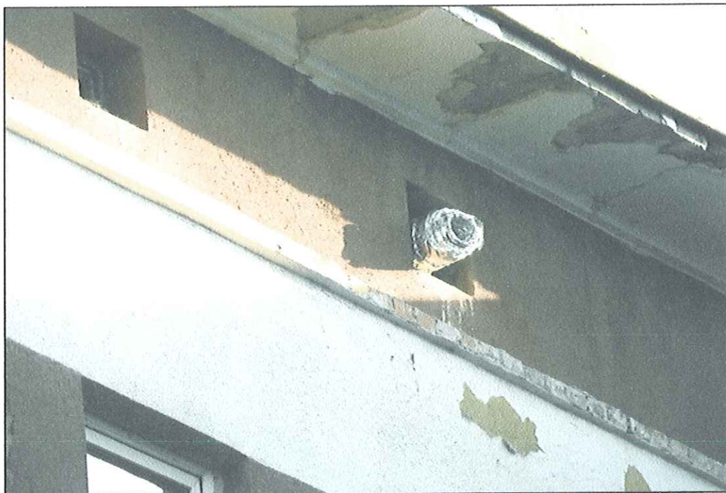
Fot. 4. Wyprowadzenie wylotu klimatyzacji w okienku potencjalny wlot do przestrzeni stropodachu dla nietoperzy – fasada północna budynku 1. Na rycinie nr 1 - punkt 9.
