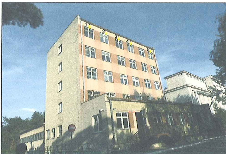
Fot. 27. Elewacja zachodnia budynku nr 9 z zaznaczonymi niezabezpieczonymi wlotami (1-5) do przestrzeni stropodachu.
