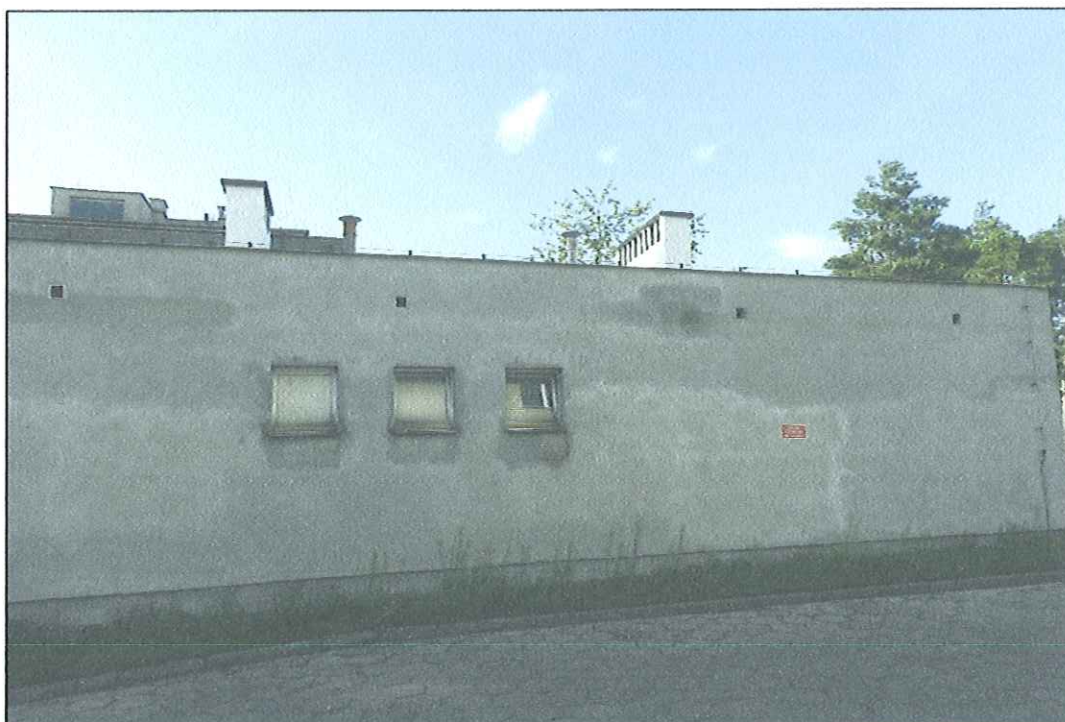
Fot. 16. Niezabezpieczone wloty wentylacji – elewacja południowa budynku nr 7. Przewody zapchane – potencjalne miejsce ukrycia i rozrodu ptaków.
