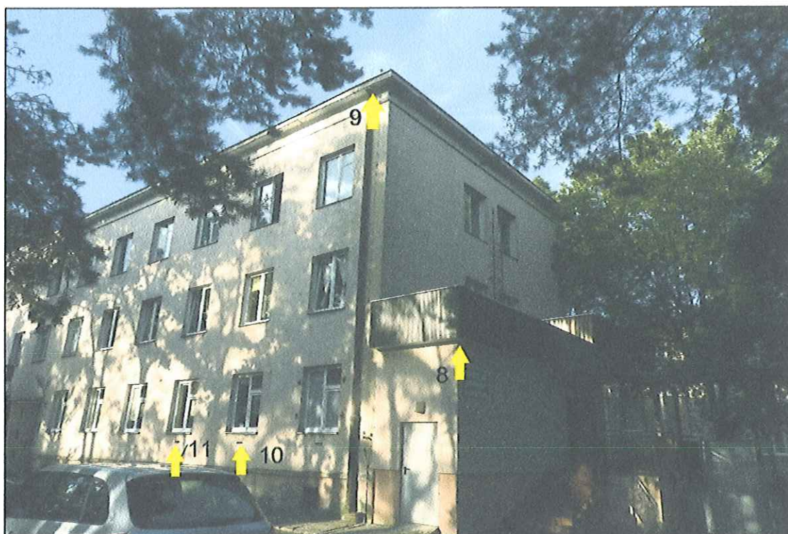
Fot. 22. Miejsca występowania ptaków i /lub nietoperzy w budynku nr 8 – elewacja zachodnia. 8 wlot do kryjówki nietoperzy, 10-11 niezabezpieczone wnęki wywietrznikowe, potencjalne miejsca lęgowe kopciuszka lub muchołówki szarej.
