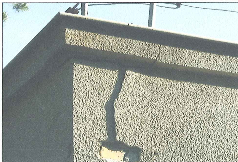
Fot. 15. Pęknięcie elewacji i muru w narożniku budynku nr 7 – potencjalna kryjówka nietoperzy. (nr 3 z fot . 14).
