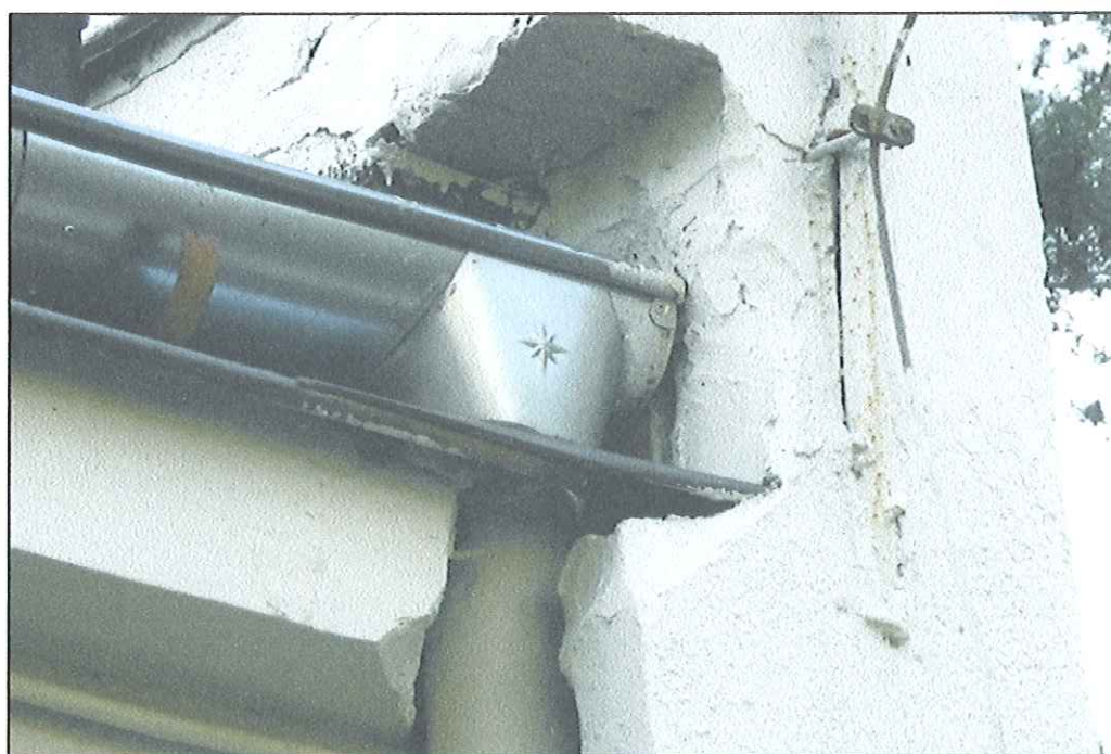
Fot. 32. Wnęka pod obróbkami blacharskimi – potencjalne miejsce lęgowe ptaków.
