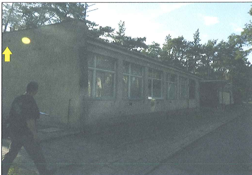
Fot. 31. Niezabezpieczone 2 wloty do przestrzeni stropodachu - potencjalne miejsca występowania ptaków lub nietoperzy.
